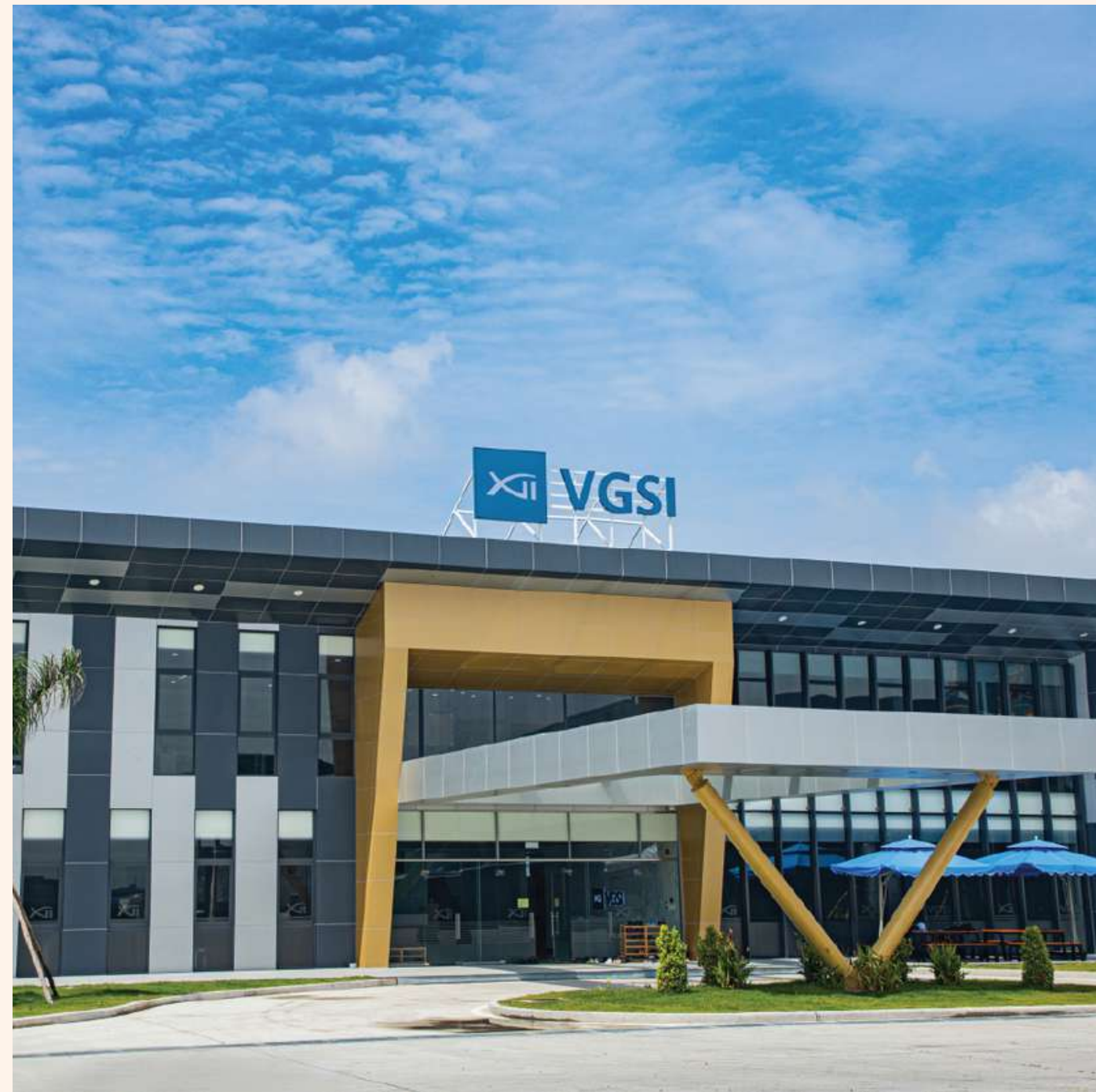
NHÀ MÁY THANG MÁY KOREA - KCN NHƠN TRẠCH 5
